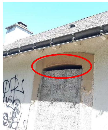
Ouverture permettant l'accès à l'intérieur du bâtiment pour les chauves-souris
